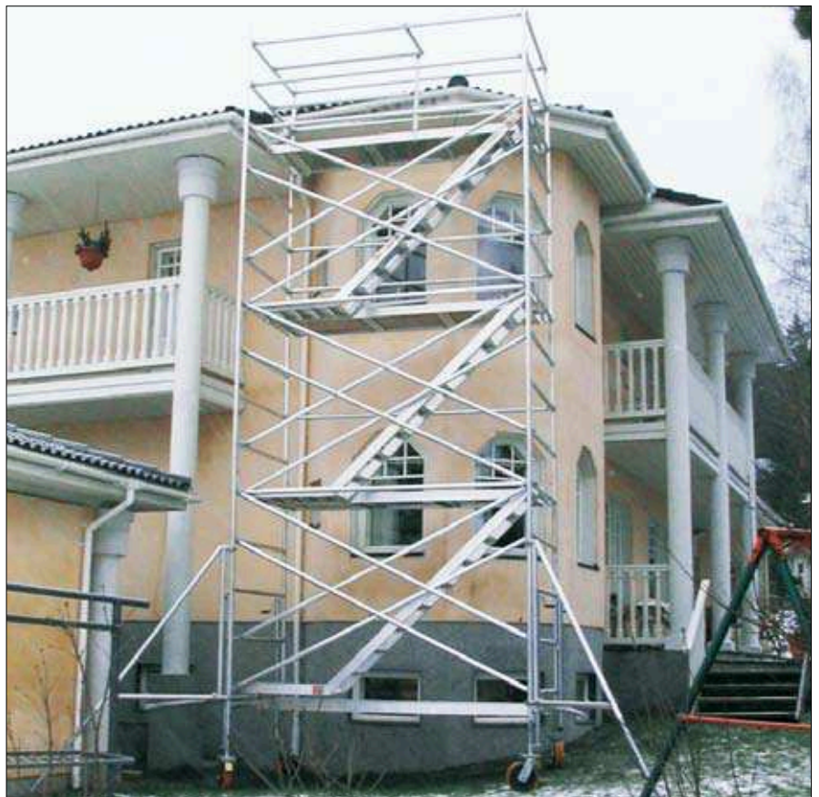
Строительные леса Usko
